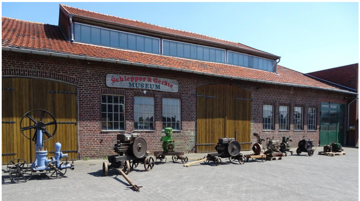
Vorderansicht Schmiede und Landmaschinen-Reparatur mit Holztafel: Schlepper & Geräte Museum. Darunter die Plakette „Denkmal“ für die seit 2010 unter Denkmalschutz stehenden Gebäude der Wesselerfabrik.
